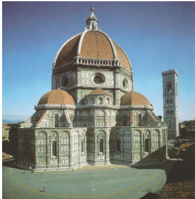
Figura 15: Brunelleschi. Santa Maria del Fiore , 1420-36, Florença. Altura: 105,50 m, diâmetro da cúpula: 51,70 m. Campanário de Giotto.
