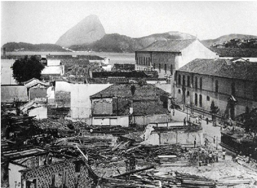
Figura 17 João Martins Torres Demolições nas proximidades do Convento da Ajuda [atual Cinelândia], 1904-05
