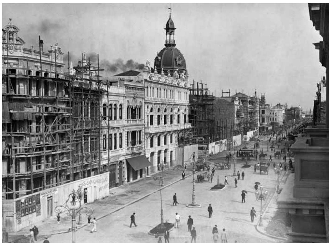
Figura 19 João Martins Torres Novos edifícios da Avenida Central já em construção, 1905-06
