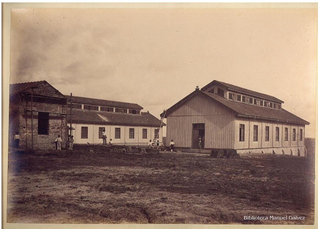
Figura 7 Emilio Halitzky Construção de hospital em pavilhões de madeira, 1885
