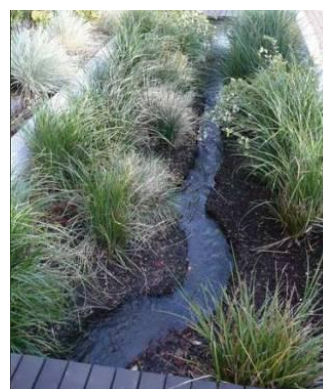
Figuras 5 e 6: Biovaleta: detalhe e aplicação. Fonte: MARTIN, 2011; Cingapura. ABC Waters Design Guidelines , 2011.
