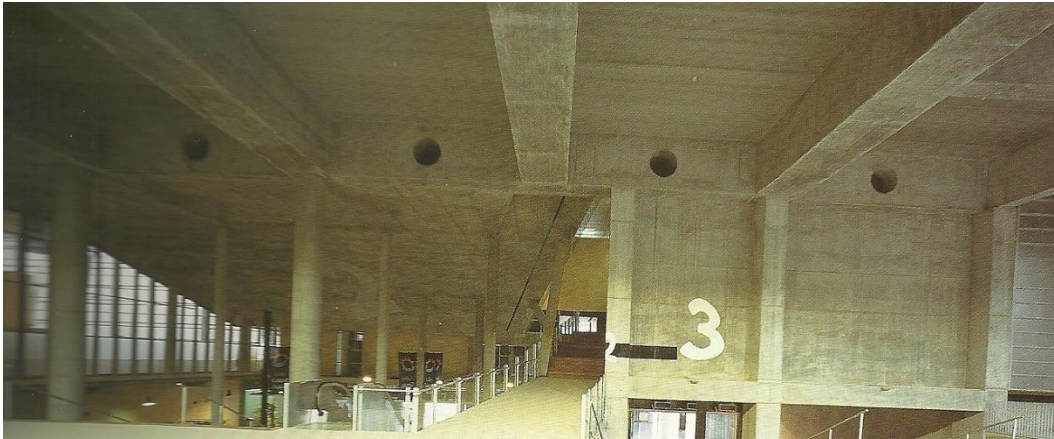
Figura 53: Espaço Interno do Congrexpo, OMA, 1994. Escadas rolantes, passarelas, escadas com degraus. Múltiplas velocidades num mesmo espaço, espaços permeáveis e com programações flexíveis. A justaposição de diferentes funções e agigantamento dos espaços internos deixam espaços para acontecimentos inesperados nas interfaces dos espaços determinados pelo arquiteto. Fonte: KOOLHAAS, Rem. Office for Metropolitan Architecture. OMA/Rem Koolhaas: 1987-1998. Madrid: El Croquis, 2005.
