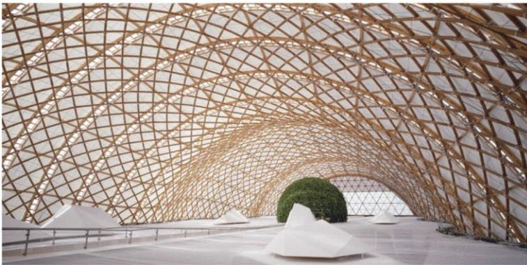
Fig. 73: Estrutura em grade curva construída por Frei Otto junto a outros arquitetos na Hannover Expo, em 2000.
