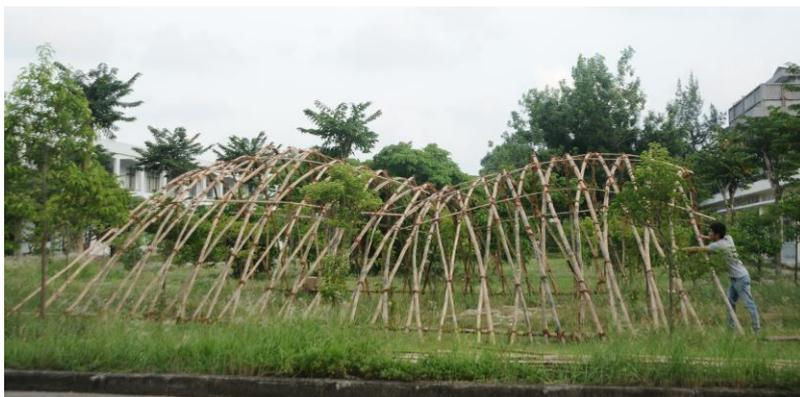
Fig. 60: Modelo de estrutura de grade curva de bambu realizado no Vietnam (Imagem extraída de Rockwood, 2013)
