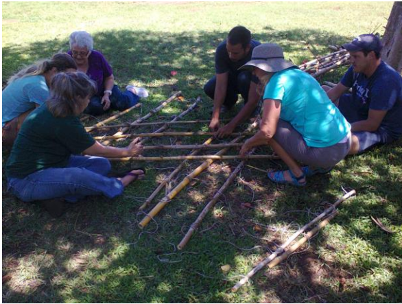
Fig. 106: Amarrações sendo feitas na treliça
