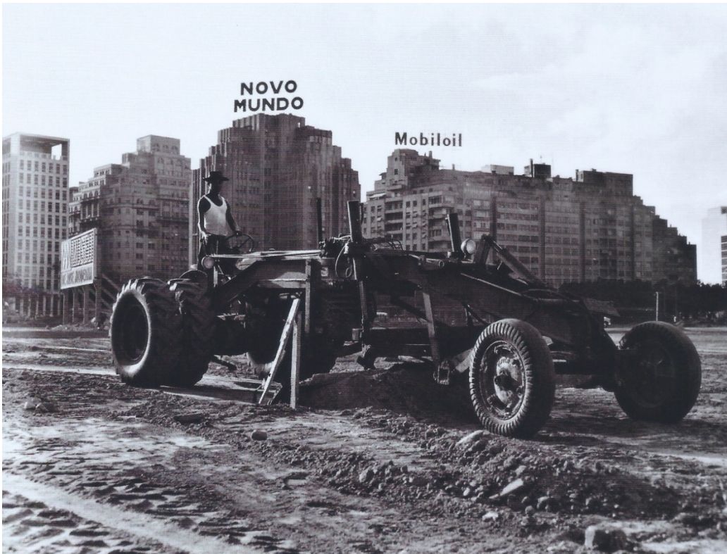
Figura 6.24 – Precursor de um “Novo Mundo”. Trabalhador opera máquina de terraplanagem nas obras do MAM. c.1955. Fotógrafo desconhecido. Acervo MAMRJ.
