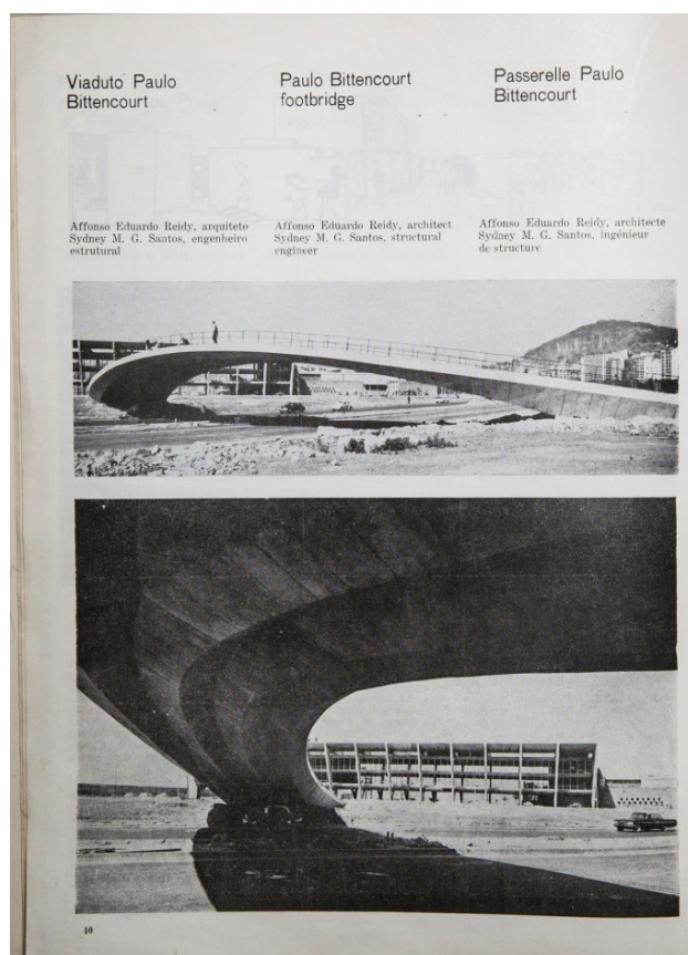
Figura 5.4 - Viaduto Paulo Bittencourt. Affonso Eduardo Reidy. 1962. Revista Módulo, n. 37, ago. 1964, p. 40. Acervo da Biblioteca da FAUUSP.
