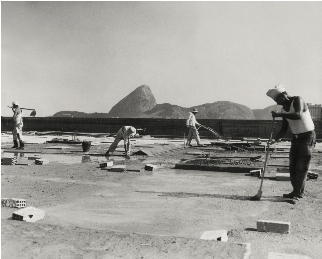
Figura 6.30 - Operários trabalham na construção do Bloco Escola do Museu de Arte Moderna. c.1955. Fotógrafo desconhecido. Acervo MAMRJ.
