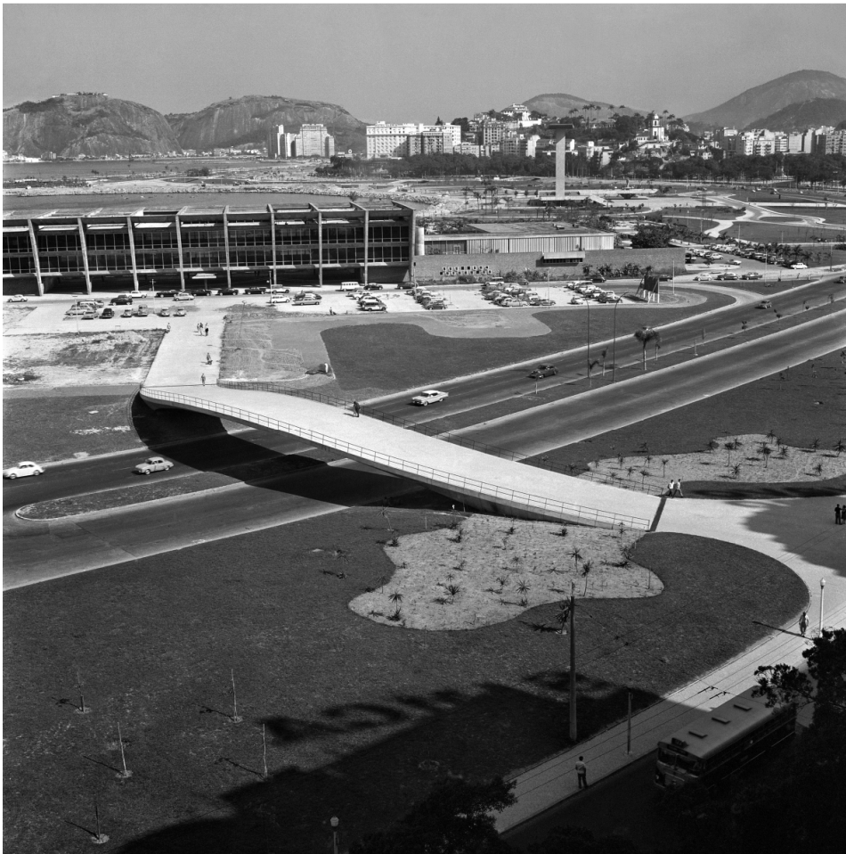
Figura 6.13 - Ponte do MAM. c.1963. Fotografia Marcel Gautherot/Acervo Instituto Moreira Salles.
