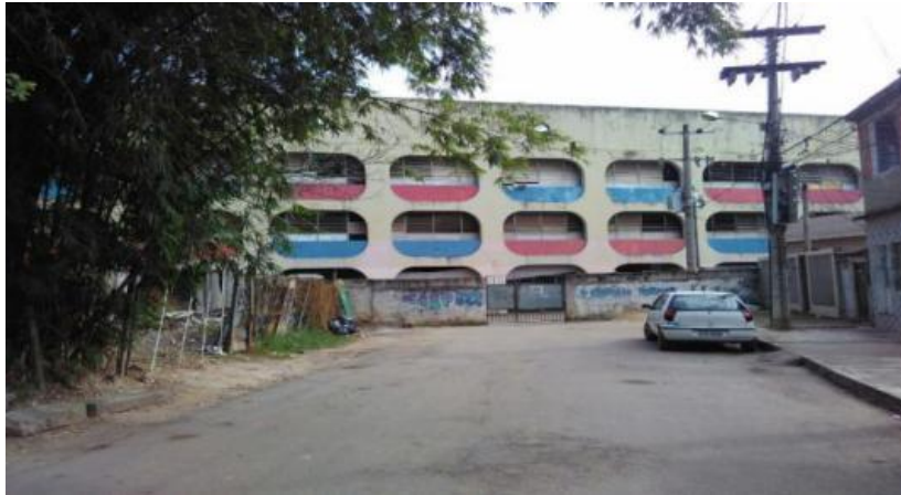
FACHADA DO PRÉDIO A PARTIR DA RUA
