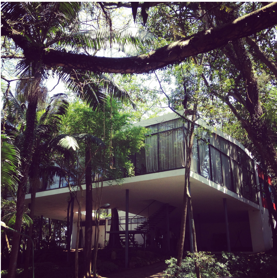
Figura 48 – Casa de Vidro, vista do térreo. Lina Bo Bardi (1951)
