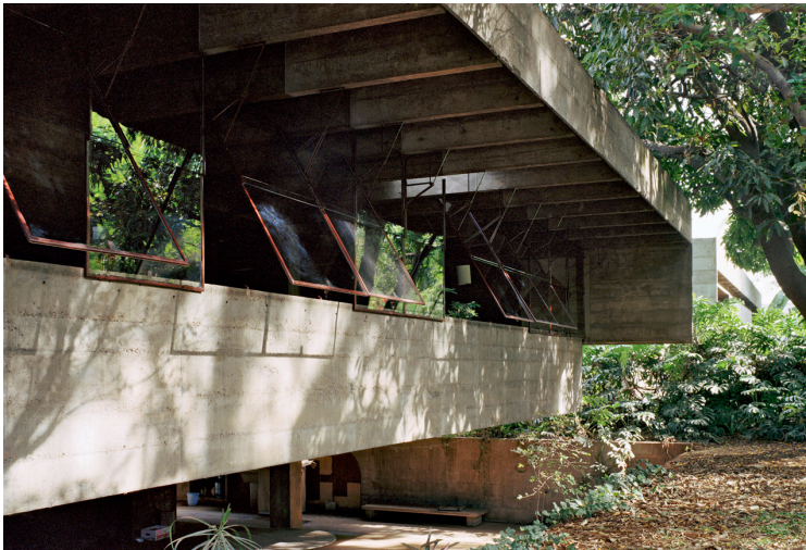
Figura 68 – Casa do Bandeirante, vista do patamar da escada principal. Paulo Mendes da Rocha (1964)
