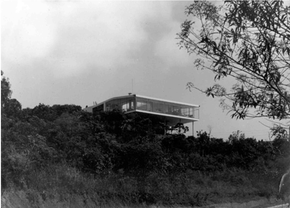
Figura 47 – Casa de Vidro, vista da casa a partir da rua General Almério de Moura na época de sua construção. Lina Bo Bardi (1951)
