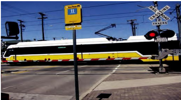
Figura 3-1 Exemplo de passagem de nível pedestres/trilhos, paralela e adjacente a um cruzamento de veículo a motor. Fonte: Fitzpatrick et al., (2015).
