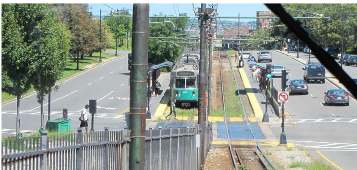
Figura 3-2 Exemplo de passagem de nível pedestres/trilhos nas estações, adjacente a um cruzamento de veículo a motor. Fonte: Fitzpatrick et al., (2014).
