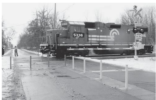
Figura 4-5 Delineadores/barreiras retráteis. Fonte: Pecheux e Saporta (2009); Cleghorn et. al., (2009).
