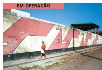
EM OPERAÇÃO NA RUA Álvaro Martins, no Jardim América, o trecho quase na esquina com a João Pessoa, visitado pelo O POVO há três semanas, estava repleto de lixo e praticamente impedia o trânsito de veículos. Hoje, pedestres já podem caminhar pela calçada.
