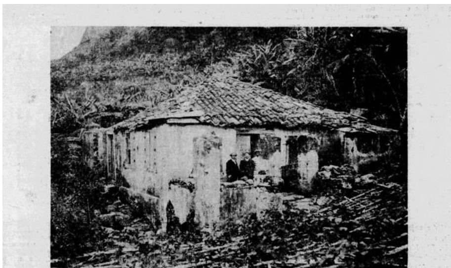
A casa em ruínas, da Estrada da Gavea n. 37, onde residia o velho Prudêncio. Junto á porta estão um «reporter» de uma folha vespertina e o nosso companheiro J. Barreiros, acompanhados do guarda civil n. 7333.
