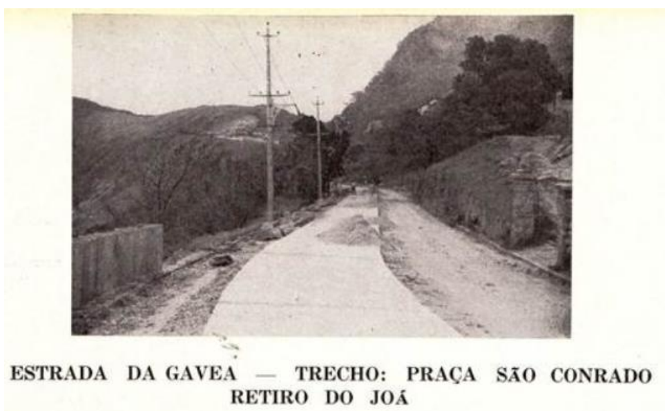
Figura 18- Fotografia das obras de pavimentação da Estrada da Gávea ( Revista Municipal de Engenharia , janeiro de 1940, número 1, volume VII).
