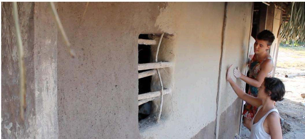
Figura 32. Processo de construção pau-à-pique do IB. Fonte: Autora.
