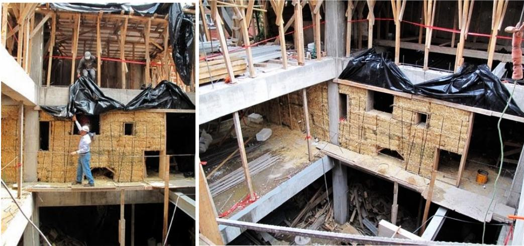
Figura 14. Proceso de construcción de edificio con cemento y fardos de paja, 2010. Fuente: Laboratorio arquitectura básica mx.
