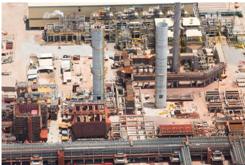
Figura 4: Unidade de abatimento de enxofre (SNOx) RNEST.
