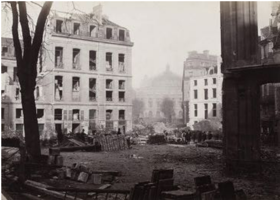
Figura 42 Charles Marville | Construction de l'avenue de l'Opéra | Paris, 1876
