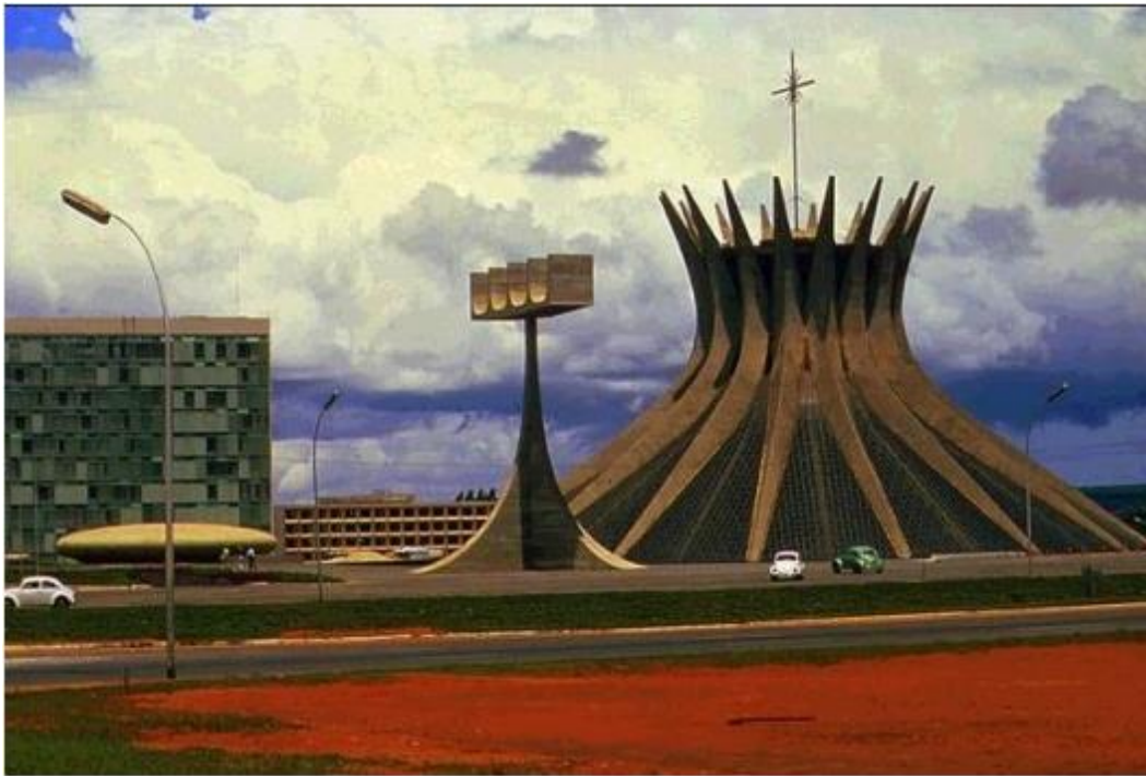
Figura 71: Catedral de Brasília. Concreto aparente, foto de 1972.
