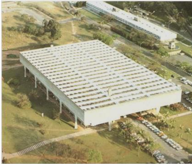
Figura 53: FAU-USP. Vista da grelha invertida da cobertura.
