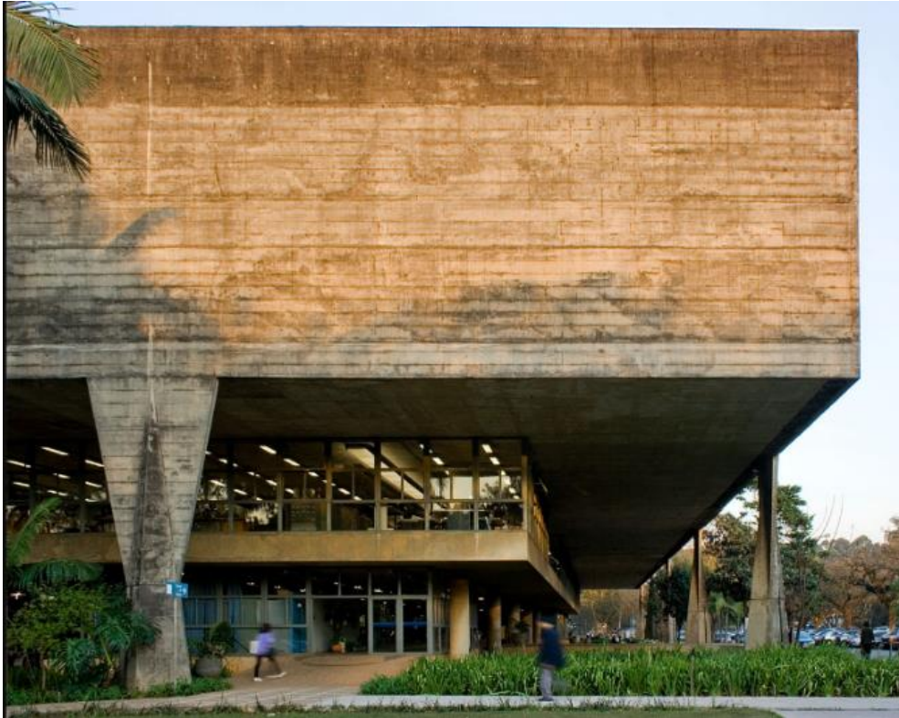
Figura 56: FAU-USP. Fachada com marcação de fôrmas.
