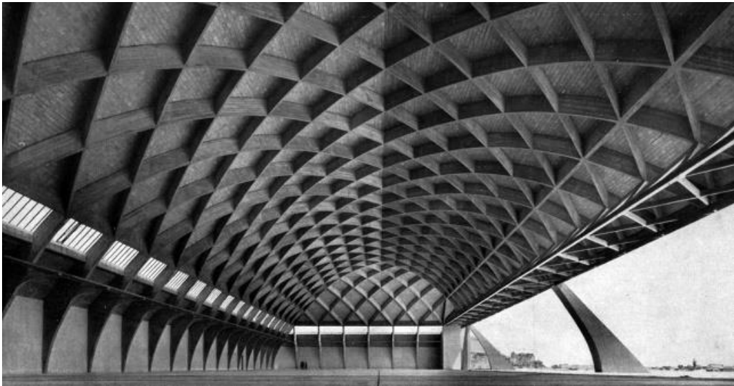
Figura 12: Hangar, Orvieto, Italia, 1935. Pier Luigi Nervi.
