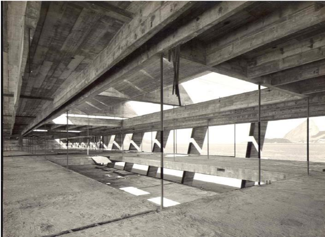
Figura 25: MAM-Rio. Foto da construção: piso do 2º pavimento suspenso por tirantes metálicos. Notas de aula do Professor Eduardo Thomaz – IME. Fonte: http://aquarius.ime.eb.br/~webde2/prof/ethomaz/mam.pdf
