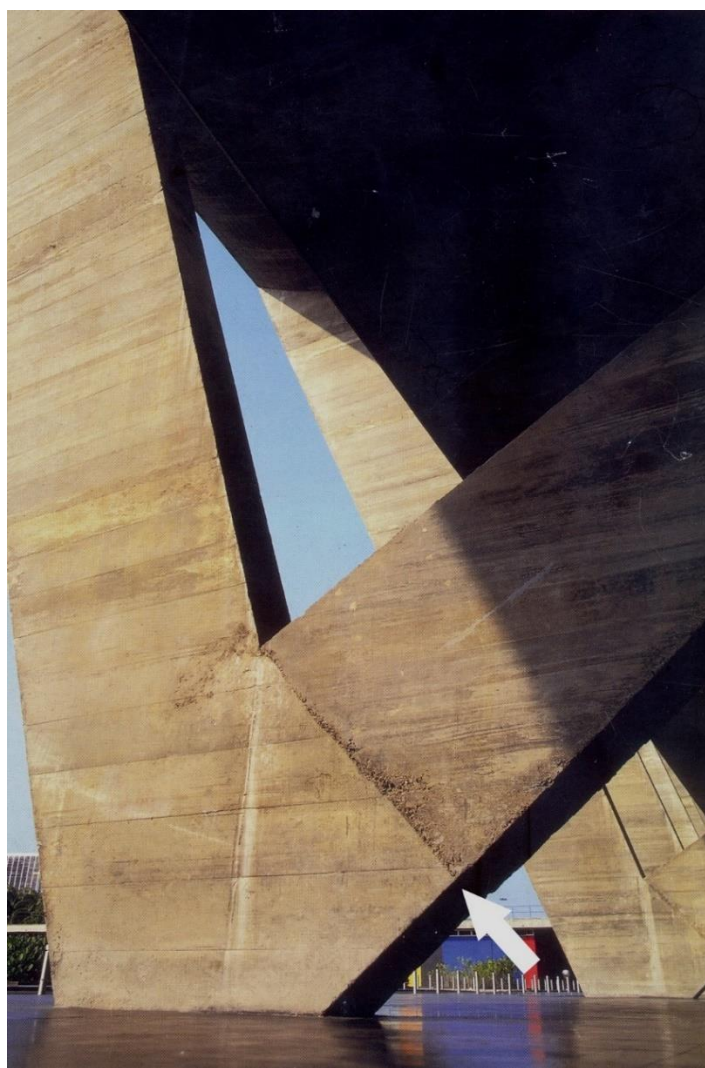
Figura 34: MAM-Rio. Marcação das juntas de concretagem. Notas de aula do Professor Eduardo Thomaz – IME. Fonte: http://aquarius.ime.eb.br/~webde2/prof/ethomaz/mam.pdf .
