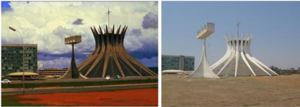
Figura 74: Catedral de Brasília. Concreto aparente, foto de 1970.
