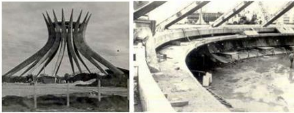
Figura 67: Catedral de Brasília. Detalhe das colunas e do anel de tração inferior. Fonte: Arquivo público do DF.
