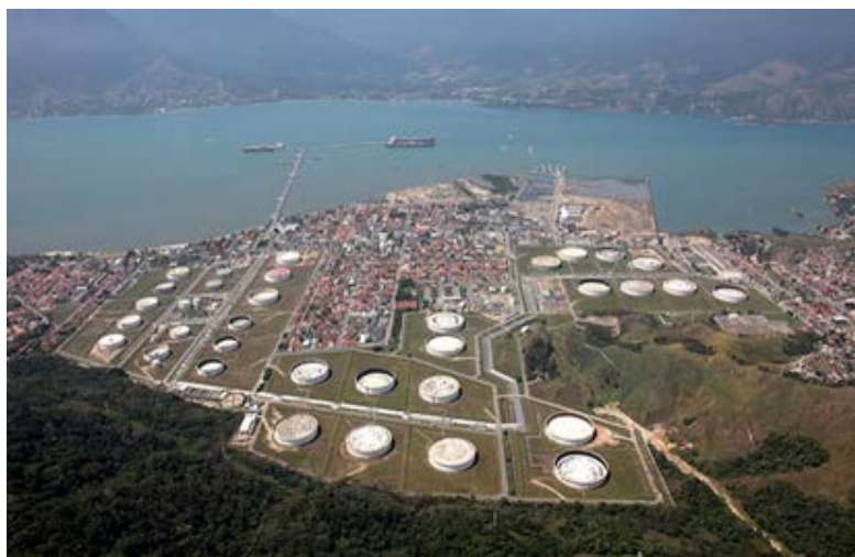
Figura 9 – Terminal Aquaviário Almirante Barroso em São Sebastião, SP.
