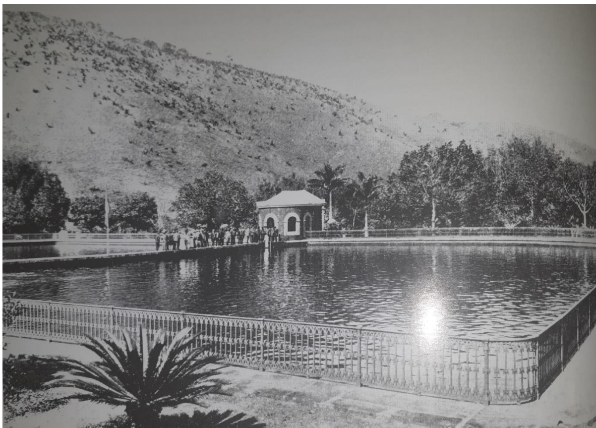
Figura 5: Reservatório Rio D'ouro, 1905 – Nova Iguaçu
