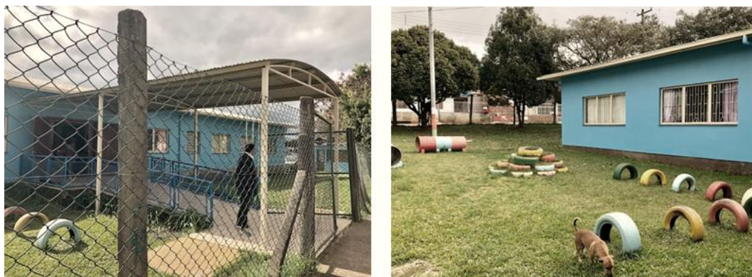
Figura 6 – Prédio da escola
