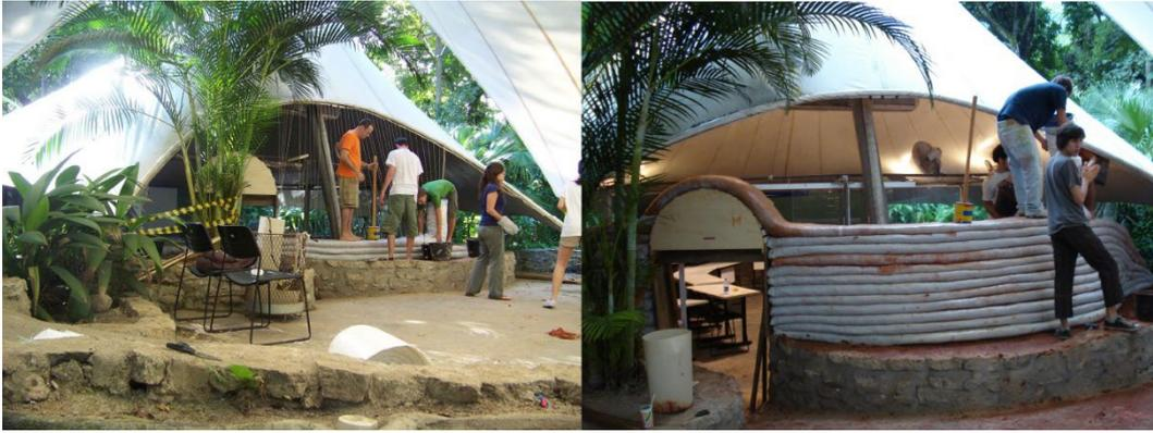
Figura 12 - Construção de muro de superadobe
