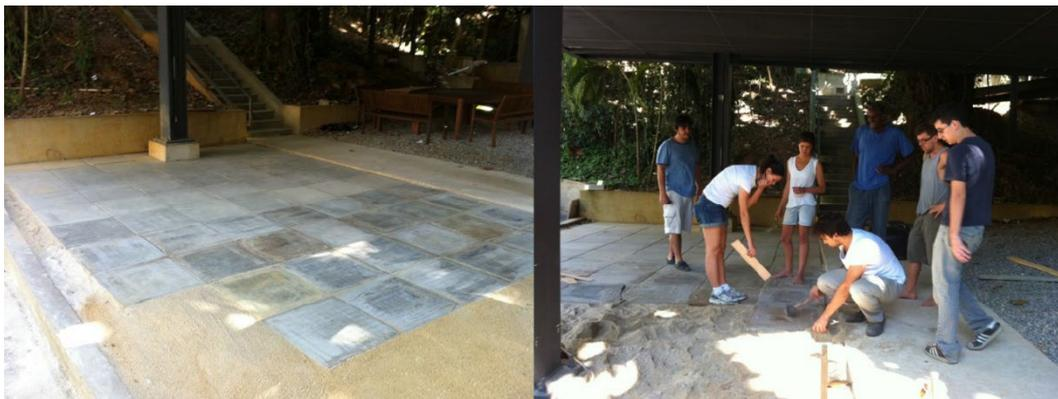
Figura 15 - Instalação dos pisos no térreo do Ed. IMA PUC-Rio.
