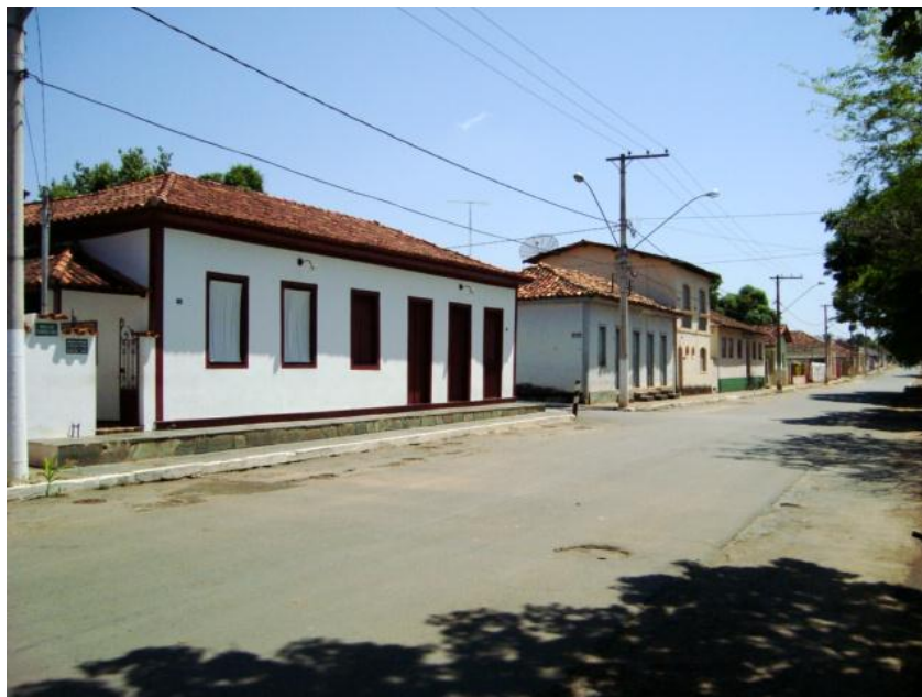
Figura 30 - Fachada do Museu Guimarães Rosa. Cordisburgo, Minas Gerais. Foto: Ivan N.Cavalcanti de Albuquerque
