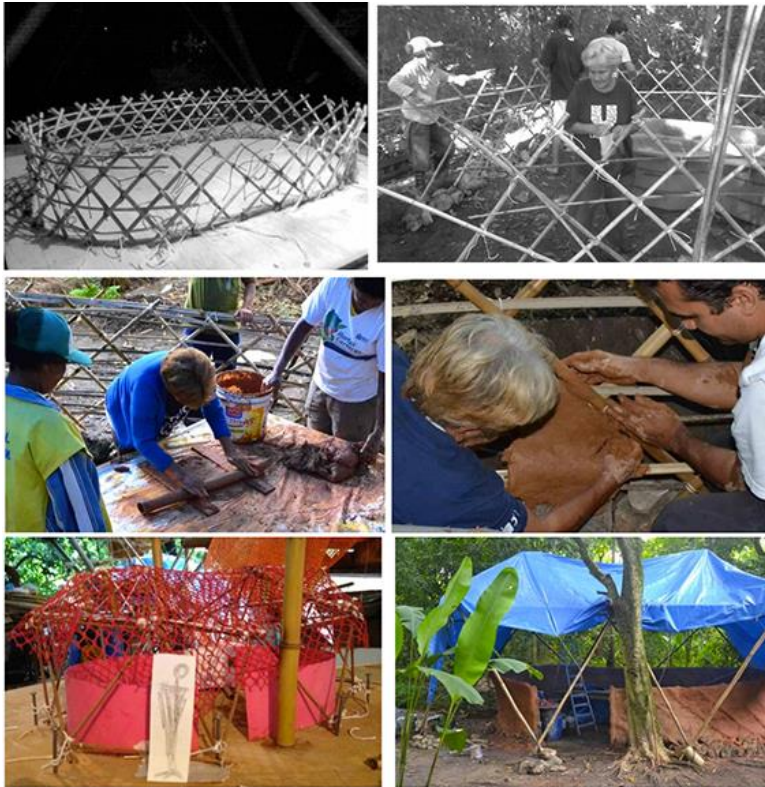
Figura 1: Quadro síntese da metodologia do LILD: Sequência de imagens do processo de construção do minhocário da horta da prefeitura no Jardim Anil. O trabalho começa com uma miniatura feita no laboratório, que depois é feita em escala real e em seguida, a pesquisa volta para o laboratório para serem repensadas soluções.
