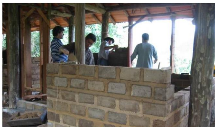
Fig. 57: Construção com tijolos de adobe coordenada por Fernando Betim Paes Leme em Itamonte, MG, com resgate de técnicas construtivas em barro.
