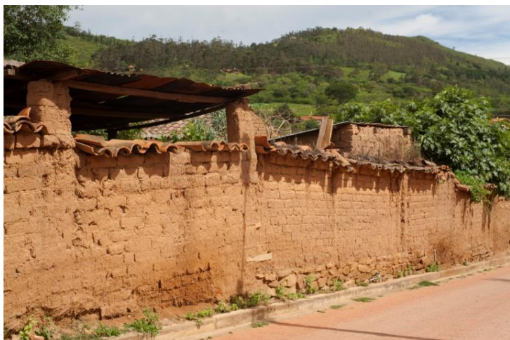
Fig. 52: Construção tradicional em adobe em Samaipata, Bolívia
