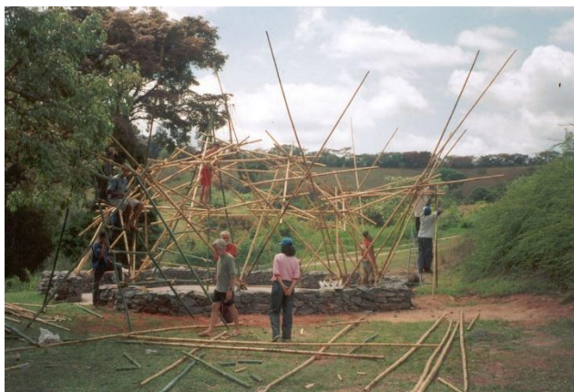
Fig. 13: Trabalho de construção coletiva da capela de Andrelândia
