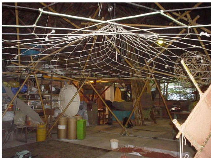
Fig. 22: Rede de cobertura de domus geodésico de bambu
