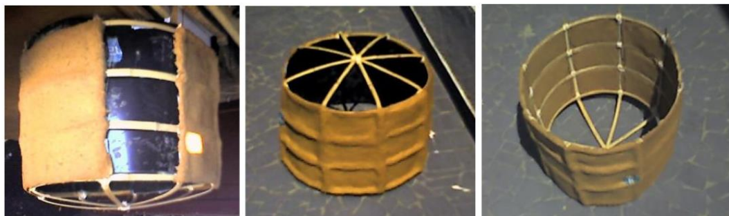
Fig. 41, 42 e 43: Processo construtivo de caixa d'água de fibrobarro armado, feita por Vicente Jesus dos Santos
