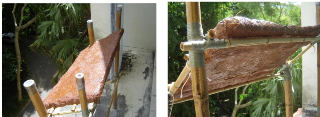
Figs. 44 e 45: Experimento de Brise soleil feito de bambu e barro, colocado em janela na PUC
