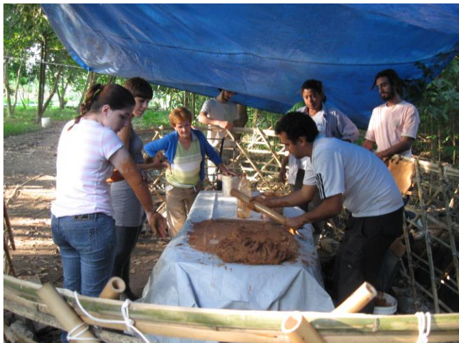
Fig. 58: O pesquisador Márcio Lazaroni explica a técnica de construção com fibrobarro para os moradores do Jardim Anil e para estudantes da PUC-Rio.
