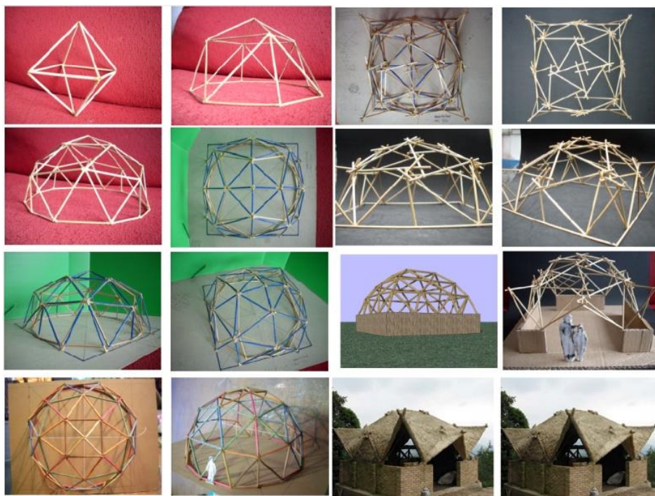
Fig. 14: Processo projetual de Daniel Malaguti na construção do domo com base quadrada do sítio de Iy Porã, em Santa Catarina.
