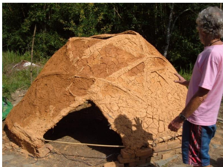
Fig. 40: Exemplo de fibrobarro armado – estrutura de bambu revestida com o compósito de barro e fibras naturais
