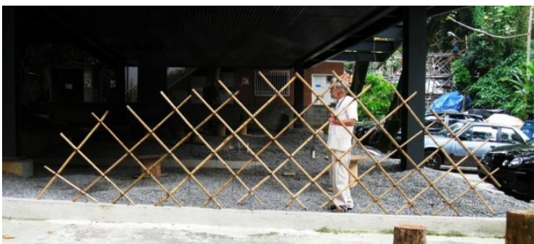
Fig. 51: Treliza pantográfica de bambu construída no LILD
