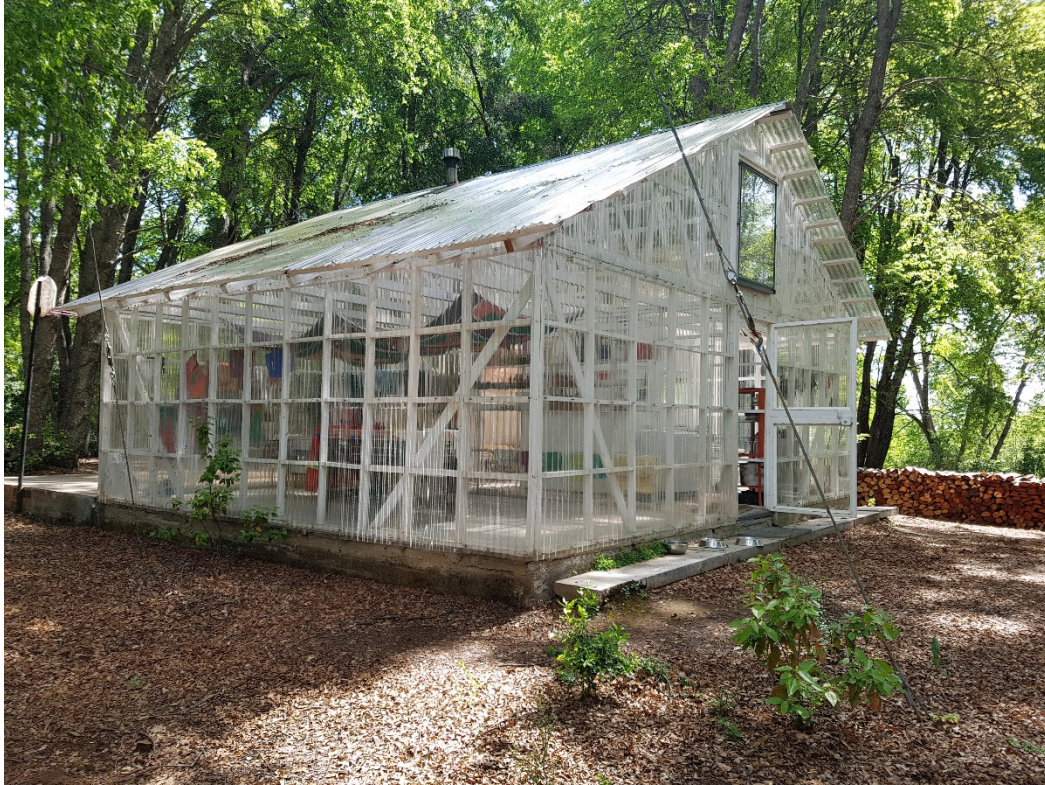
Figura 73: Casa Transparente: foto exterior. Fonte: o autor.
