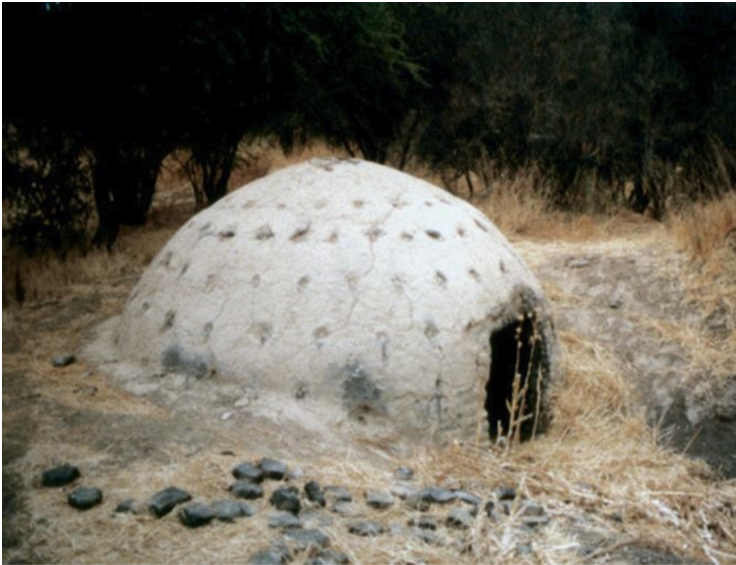
Figura 33: Forno de carvão tradicional. Fonte: El Croquis n.167 - Smiljan Radić: 2003-2013, p. 12.
