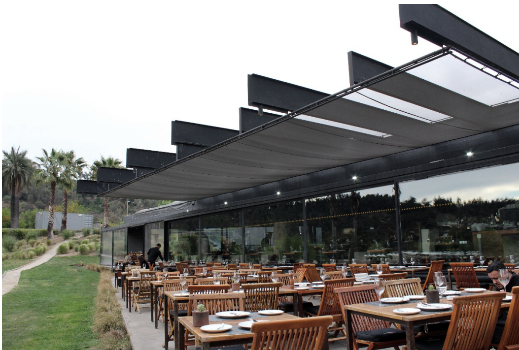
Figura 55: Restaurante Mestizo: foto externa. Fonte: o autor.
