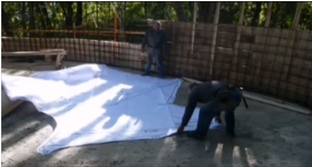
Figura 86: Casa para El Poema del Ángulo Recto: Impressão do projeto em escala 1:1 na obra. RADIC, S., 2015. In: CONFERENCIA DE LA CATEDRA BLANCA, 51:06.
