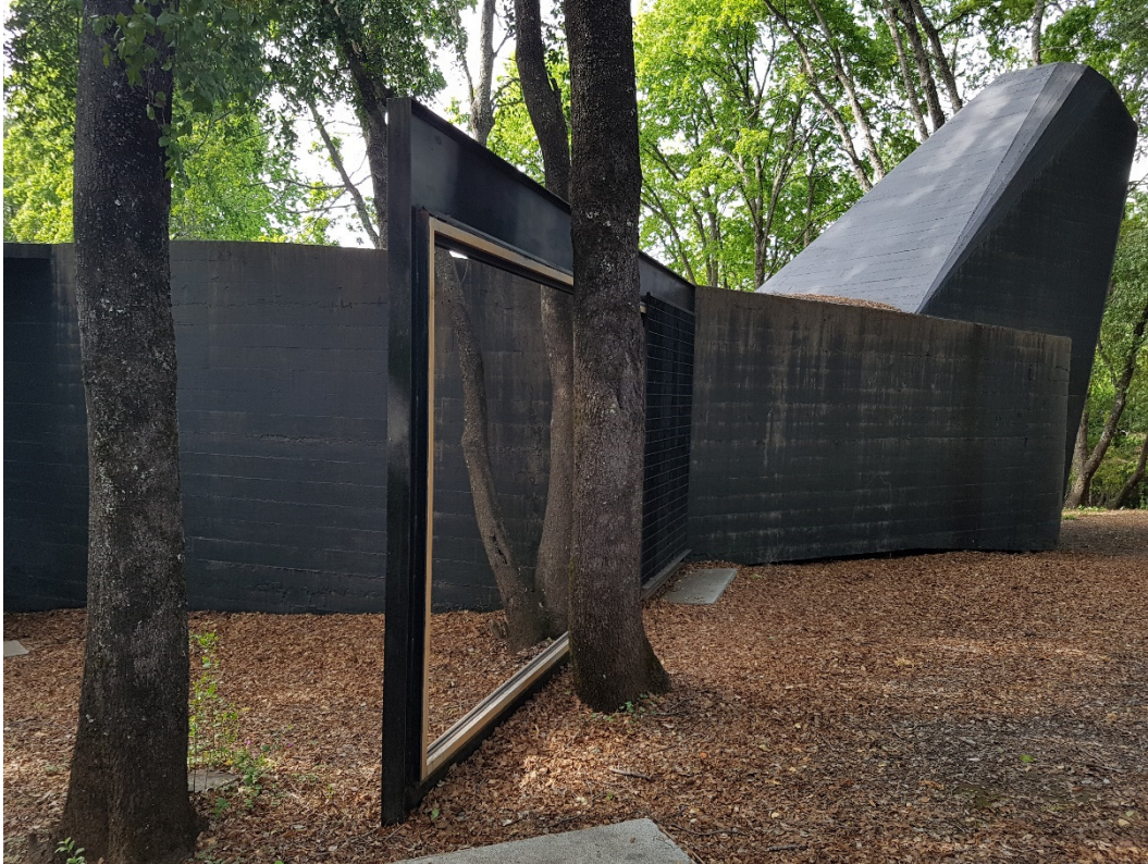
Figura 93: Casa para El Poema del Ángulo Recto: detalhe da estrutura metálica. Fonte: o autor.
