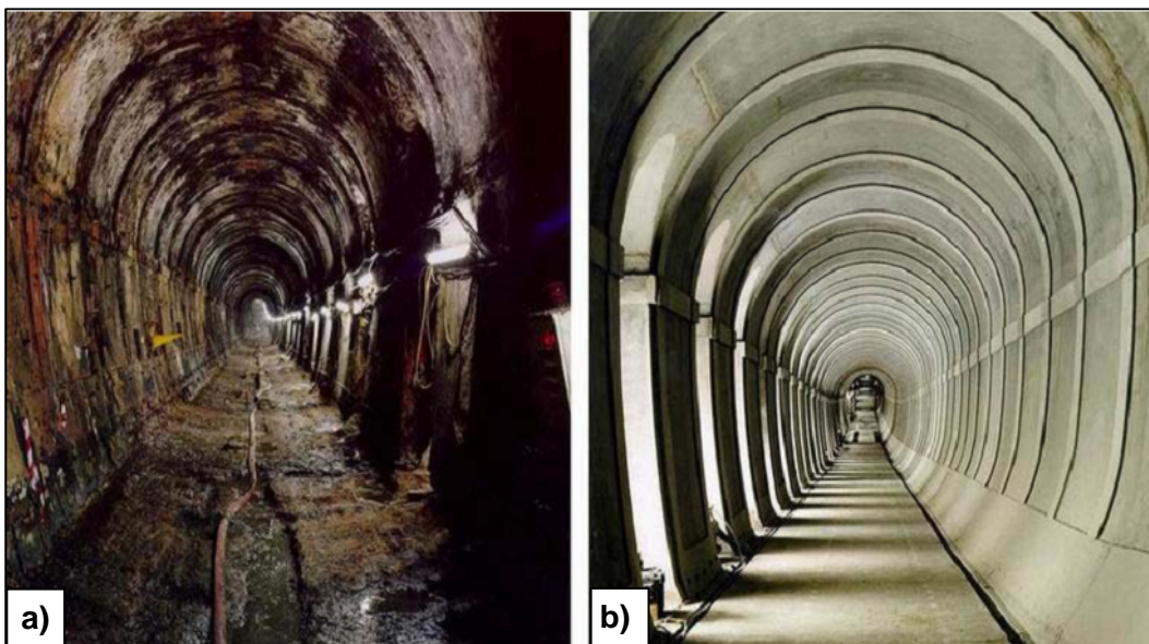
Figura 2-5. Túnel de Brunel construído sob o Rio Tamisa na década de 1830-Londres, UK: a) 1995 e b) 1997-Túnel após reabilitação com revestimento interno em concreto moldado (Sauer e Mergelsberg, 2004).
