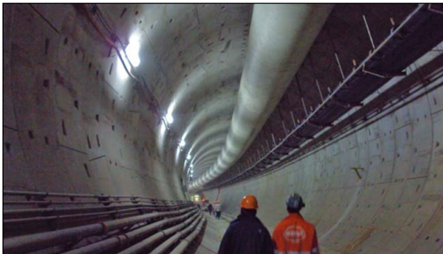
Figura 2-23. Revestimento de aduelas de concreto pré-moldadas. Túnel do metrô Linha 4 amarela, São Paulo (Palma et al. , 2014).
