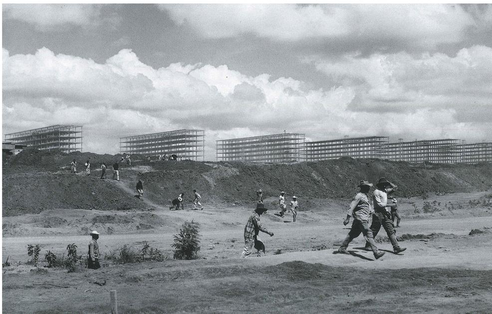
**Fig.44.** Terrapleno da esplanada dos ministérios com a estrutura das lâminas já construídas. Foto: Marcel Gautherot. Fonte: Acervo IMS. In: Acervo Brasília
