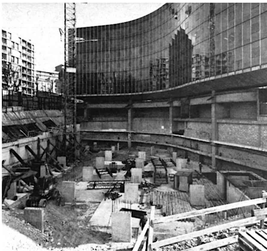
**Fig.20.** Construção do subsolo do edifício do Partido Comunista Francês. Arquiteto Oscar Niemeyer. Reconstrução do solo enquanto arquitetura.
