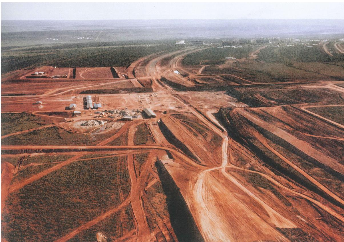
**Fig.55.** Movimento de terra que planificou a área onde veio a se construir a Plataforma. Observa-se a preparação das estradas do eixo residencial e a conformação dos taludes que limitam o eixo monumental. Foto: Mario Fontenelle. Fonte: Arquivo Público do Distrito Federal. In: Acervo Brasília
