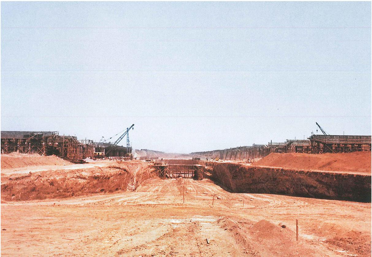
**Fig.56.** Escavação do “buraco do tatu”. Este corte delimitou o trecho onde hoje se instala a via de tráfego direto do eixo residencial que atravessa a Plataforma sem paradas. Observa-se a implantação dos primeiros pórticos da estrutura da Plataforma. Foto: Mario Fontenelle. Fonte: Arquivo Público do Distrito Federal. In: Acervo Brasília
