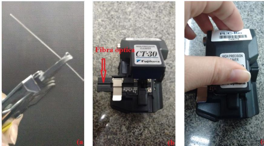
**Figura 10- As etapas da clivagem: a) Processo da retirada do revestimento da fibra, com o auxílio de um alicate de desencape. b) Fibra posicionada no clivador. c) Com um leve clique, a fibra é clivada.**
