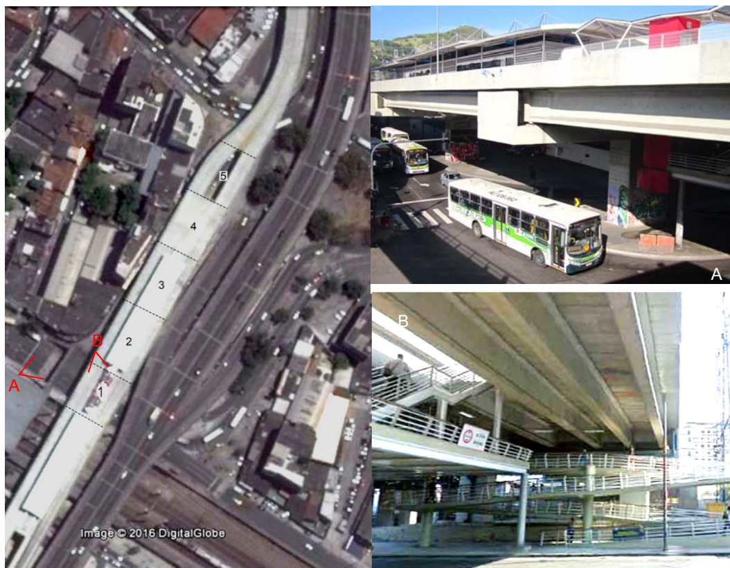
Figura 29: Zona 1, Trama 1, Madureira, Rio de Janeiro Fonte: Google Earth (2016) e fotos pessoais (2016)
