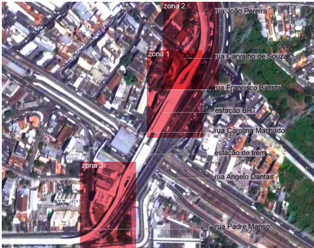
Figura 28: Viaduto do BRT em Madureira, Rio de Janeiro
