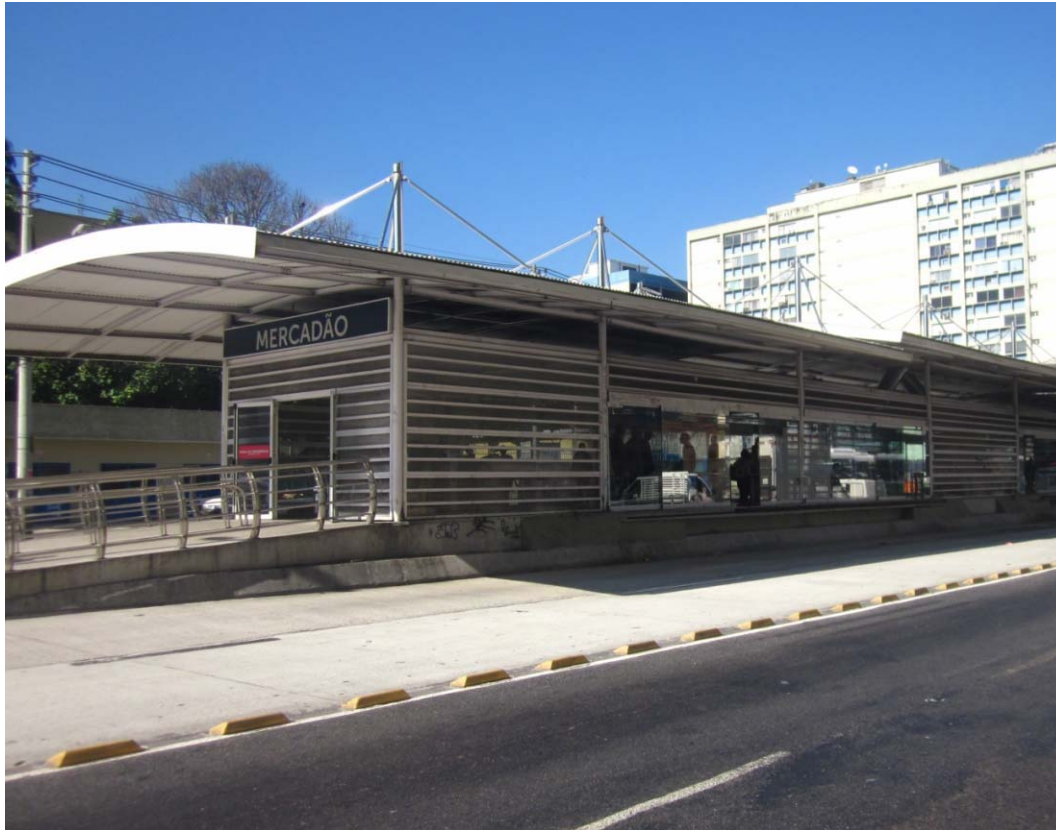
Figura 24: Estação de BRT de Madureira, Rio de Janeiro.
