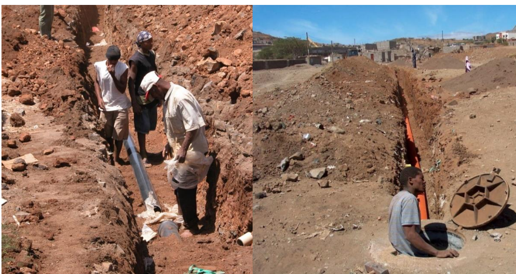
Figura 31: Instalação de rede de água e esgoto Fonte: CMP, 2005, p.74
