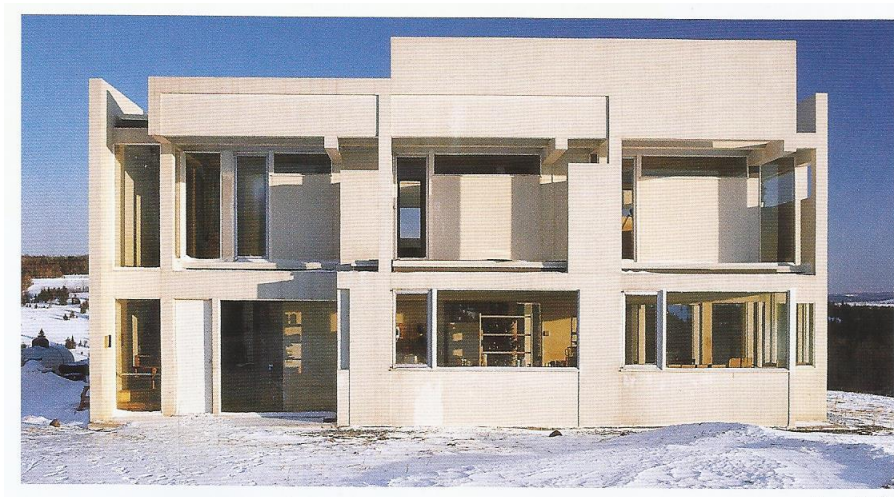
Fig. 18 Fachada Casa II
