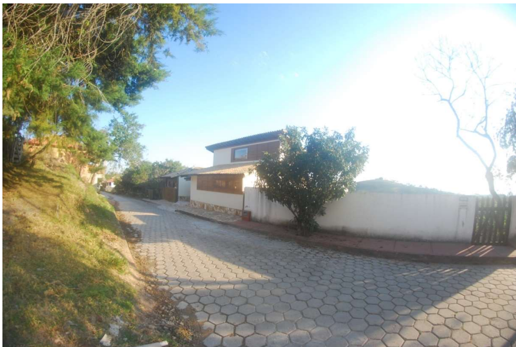
Figura 48 - Arquitetura fora do padrão construtivo normativo. Fonte: 2019.
