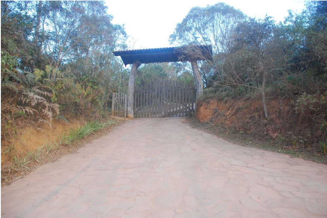
Figura 74 - Entrada de um condomínio rural. Fonte: Autor, 2019.
