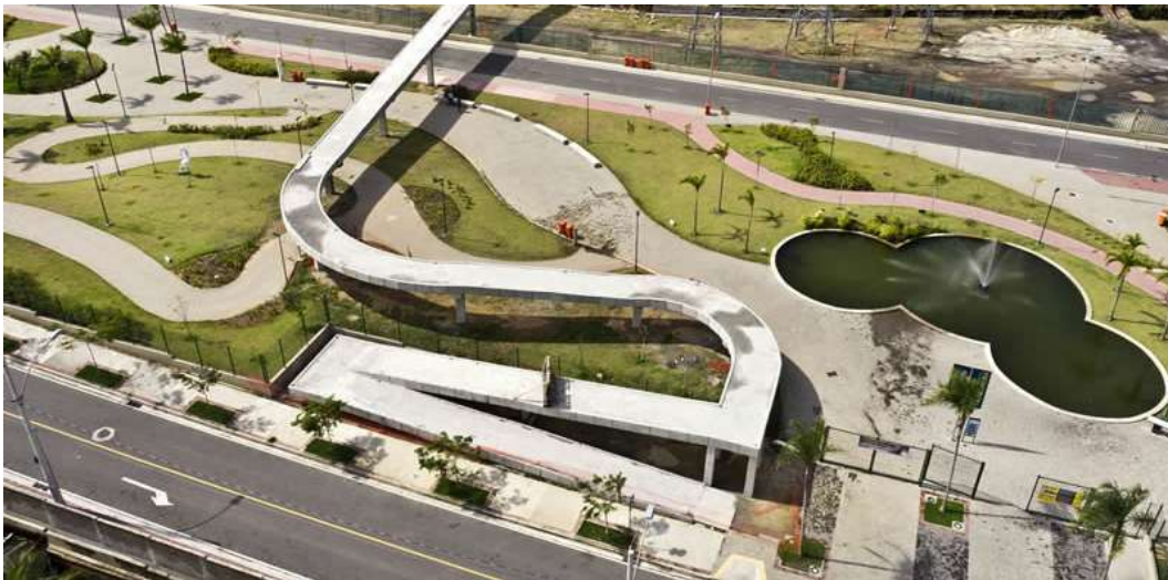
Figura 79: Vista aérea do terreno próximo à entrada na rua Antônio Abreu
