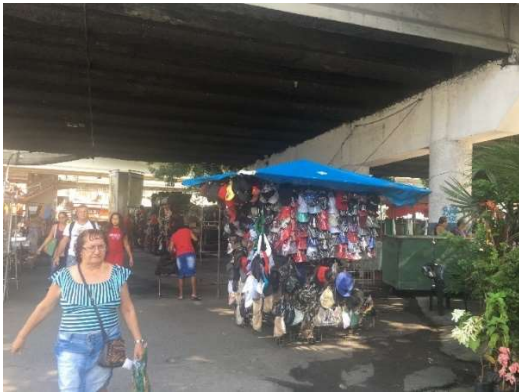
Figura 19: Comércio ambulante sob o viaduto Prefeito Negrão de Lima
