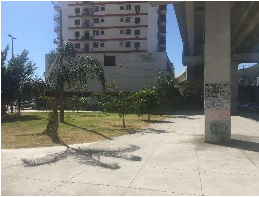
Figura 17: Calçada próxima a descida do viaduto Silas de Oliveira
