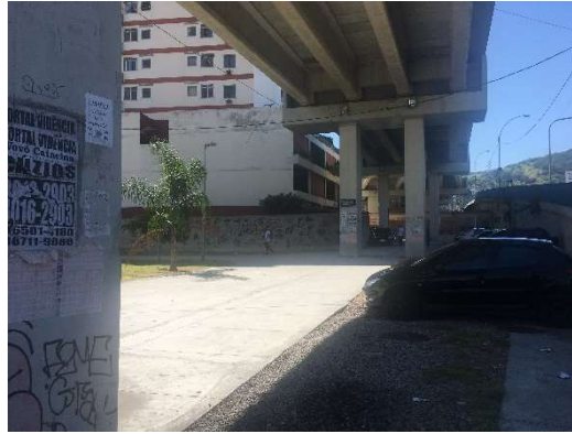
Figura 18: Estacionamento sob o viaduto
