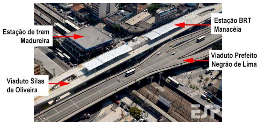
Figura 27: Vista aérea aproximada dos viadutos
