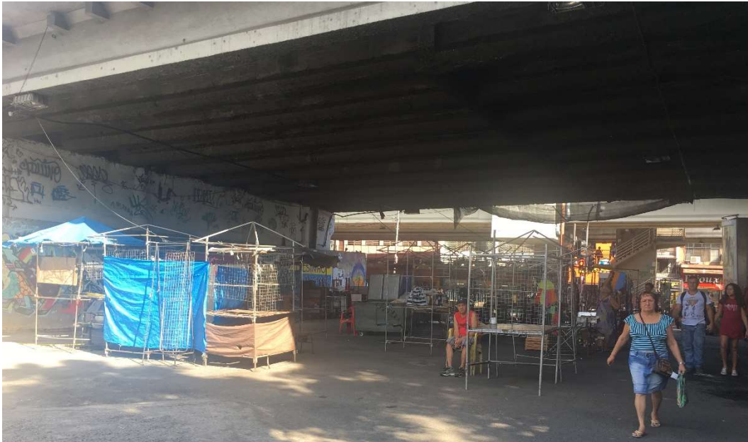
Figura 64: Viaduto servindo como cobertura e abrigo para os comerciantes informais
