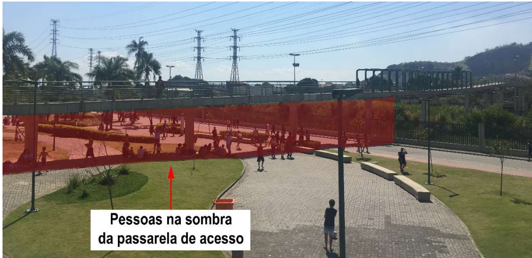
Figura 81: Uso das passarelas como proteção solar
