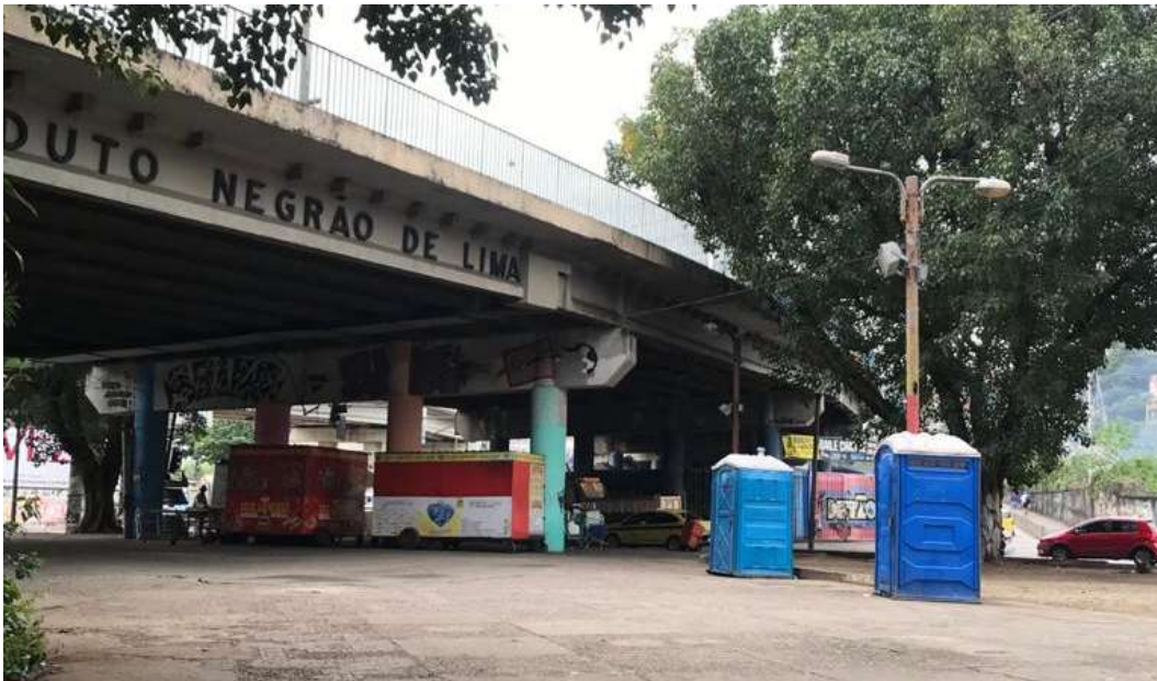
Figura 54: Área 2 utilizada para armazenamento dos trailers e banheiros químicos
