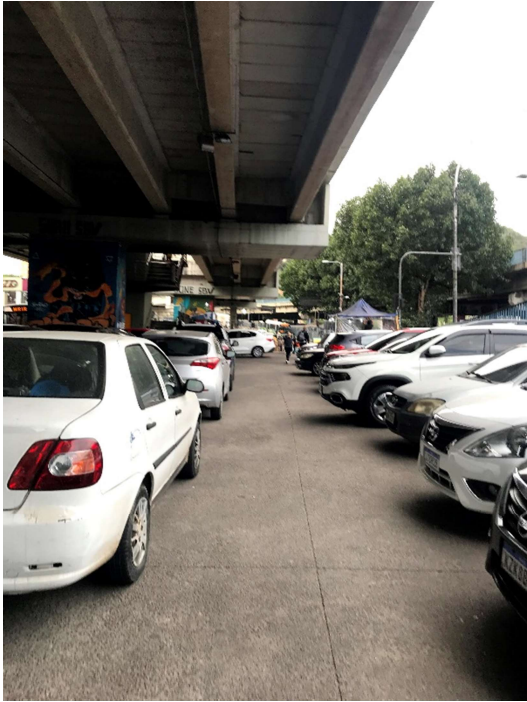
Figura 40: Calçada sob o viaduto Silas de Oliveira em dias úteis
