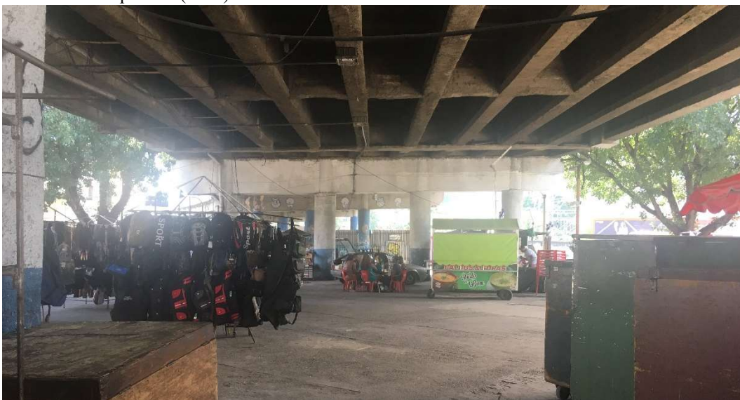
Figura 65: Viaduto servindo como cobertura e abrigo para os comerciantes informais
