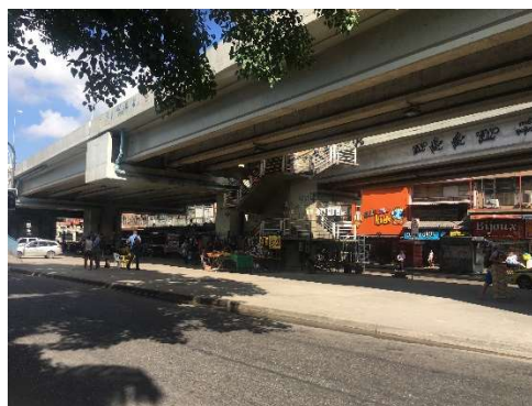
Figura 33: Viaduto Silas de Oliveira
