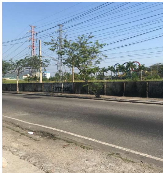
Figura 15: Muro da Supervia entre a área residencial e o Parque Madureira
