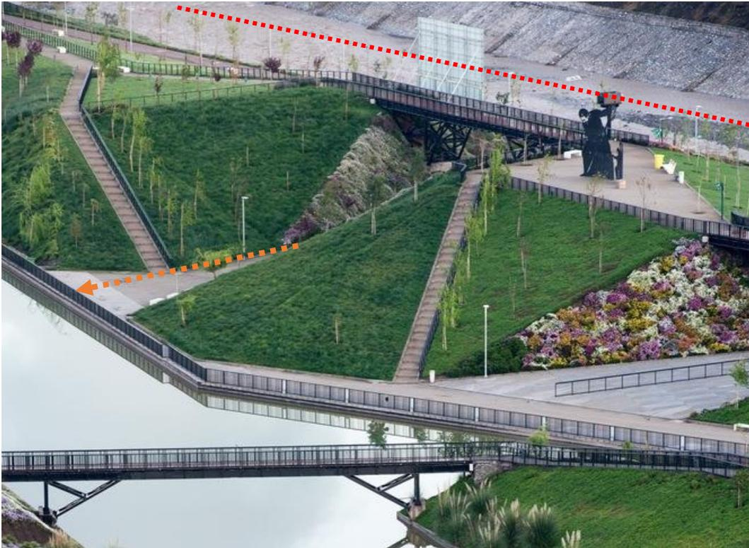
Figura 29 - Entrada das águas fluviais em caso de inundação. A linha em vermelho é rio Mapocho e em laranja representa essa possibilidade de retenção das águas. Fonte: Parque (2016), adaptado pela autora.
