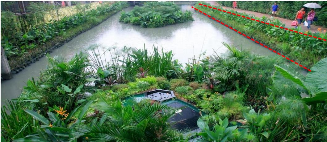
Figura 45 - Ilhas de aeração no Mercado de Paco. Os *wetlands*, que o relatório de desempenho se refere são essas camadas de margem vegetada, destacadas em vermelho, construídas para auxiliar na infiltração e redução de poluentes que chegam às águas. Fonte: Biomatrix Water<sup>89</sup>, adaptado pela autora.
