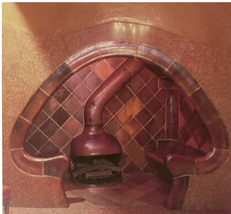
Figura 9: Casa Batló , Barcelona, Espanha. 1904-6. Lareira do segundo pavimento.
