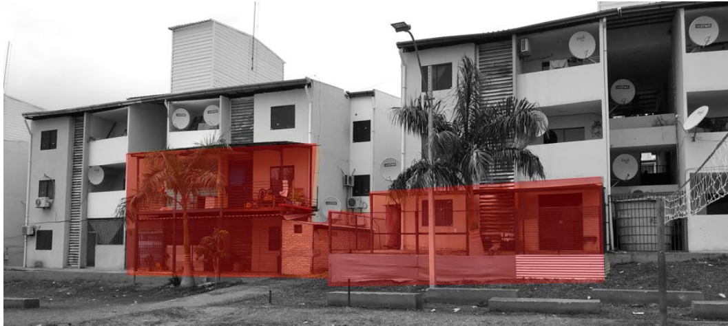
Fig. 25 – Extensão dos apartamentos mediante a construção de laje e cobertura na parte dos fundos. Acervo próprio. Ano 2022
