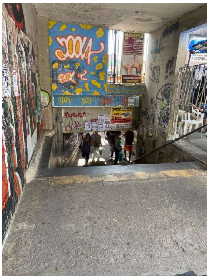
Figura 97: Acesso à passagem de nível, pela Área 03, 2024. Fonte: acervo pessoal.
