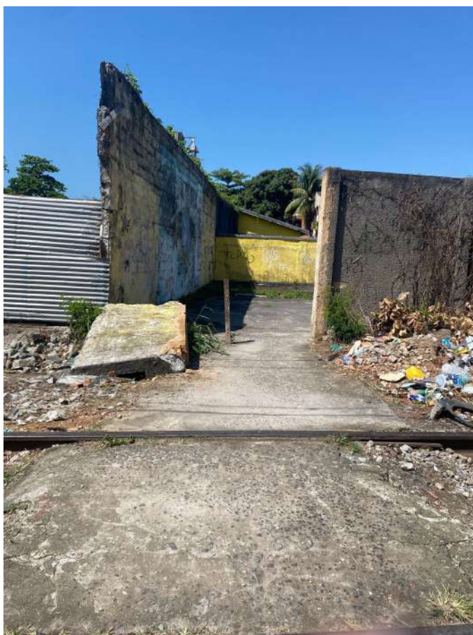
Figura 89: Trecho do muro removido, em uma das travessias entre as Áreas 02 e 03, 2023. Fonte: acervo pessoal.
