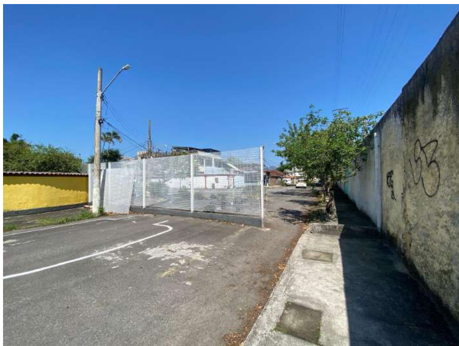
Figura 90: Tentativa de resistência à conexão, através da instalação de gradis, entre as Áreas 02 e 03, 2023. Fonte: acervo pessoal.
