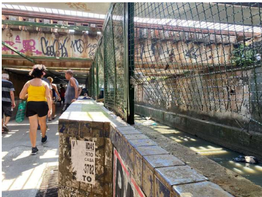
Figura 98: Passagem de nível, sob linha férrea (Supervia), em direção à Área 02. Ao lado do canal, 2024. Fonte: acervo pessoal.
