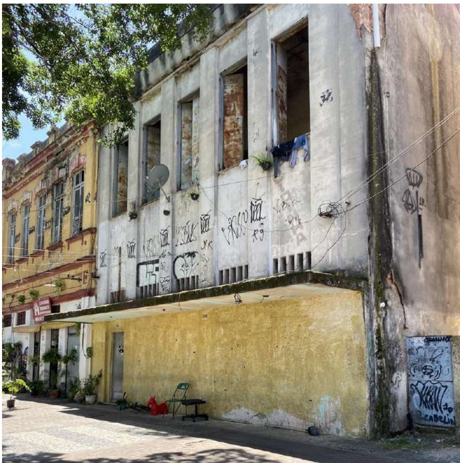
Figura 47: Ocupação de prédio histórico, em frente à Avenida General Osvaldo Cordeiro de Farias - Área 01 (A1), 2023. Fonte: acervo pessoal.
